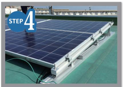
パネル設置後、PV押え金具で、固定する
