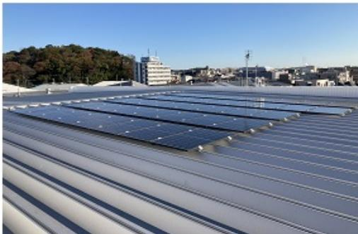
年間発電量は1万4,576kWhを見込み、これにより6,602kgのCO<sub>2</sub>を削減する。太陽電池はネクストエナジー・アンド・リソース製345kW。このほかシーケンスエナジーの1.5kWhポータブル蓄電池もゼロ円で導入。災害時には近隣の利用も含めた
